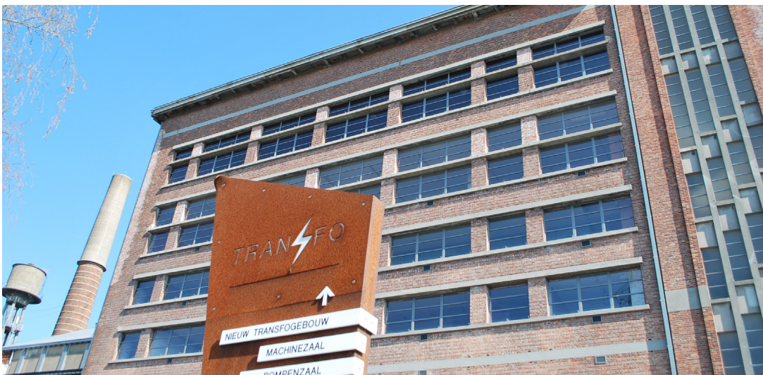
Herbestemming Nieuw Transfogebouw
